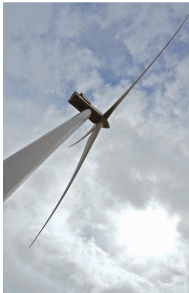
A Green Hill Turbine (Vestas 2.0MW)
